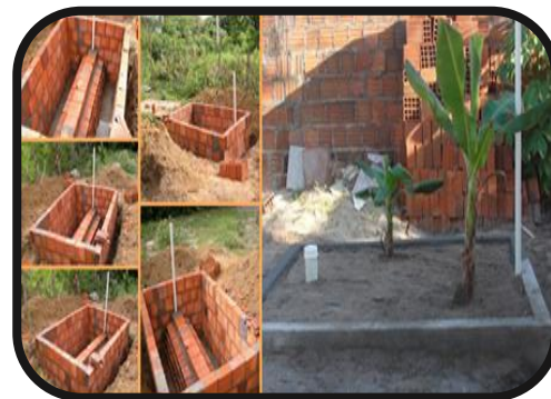
No campo do saneamento básico
